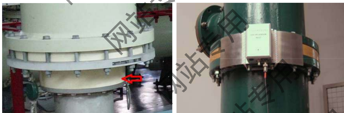
图A.1 GIS局部放电带电测量传感位置
